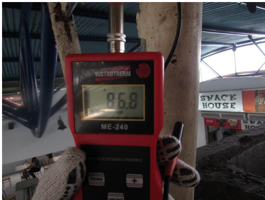
Figura 14 - Medição da camada de proteção superficial
