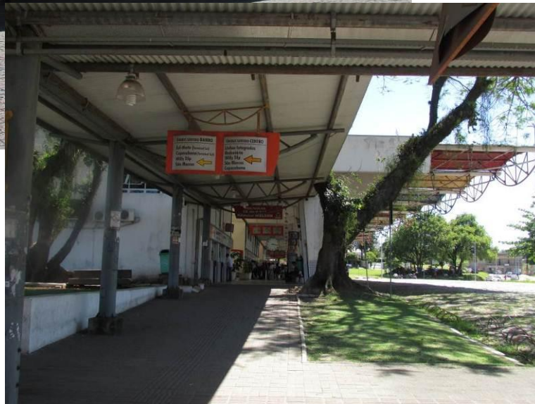
Figura 47 - Vista da passarela
