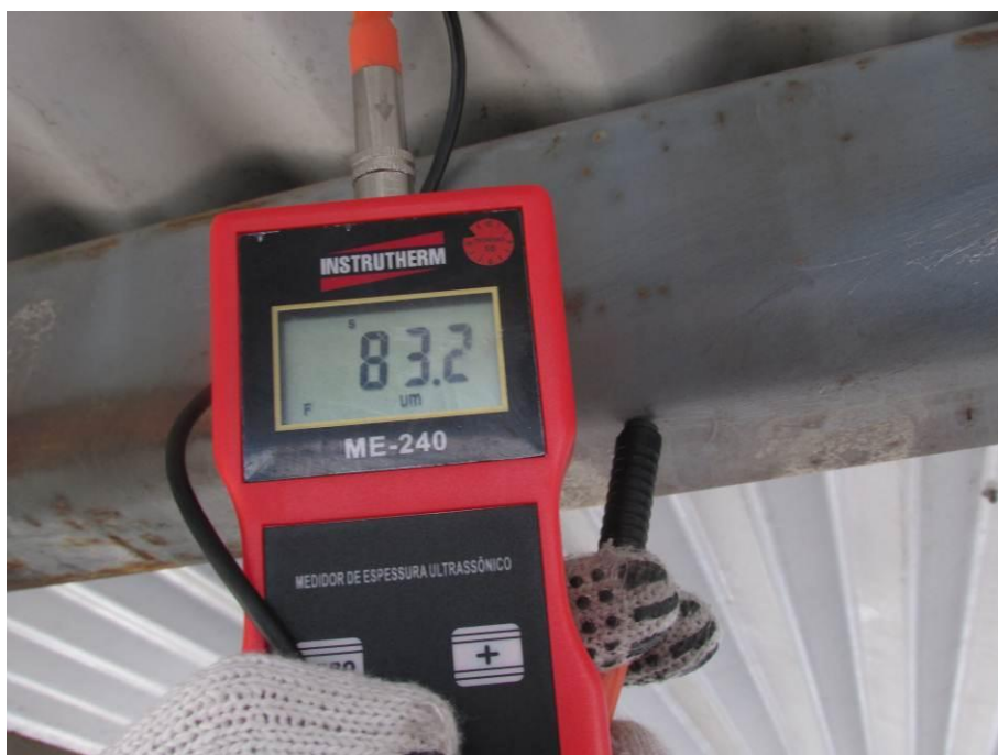
Figura 29- Medição da camada de tratamento superficial
