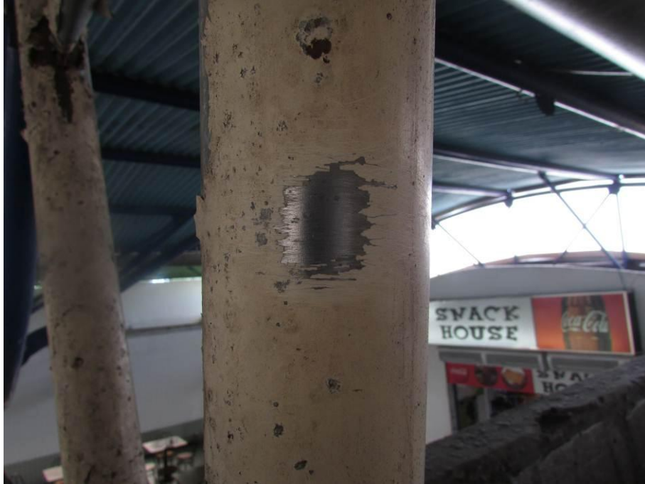
Figura 12 - Lixação manual até base de zinco
