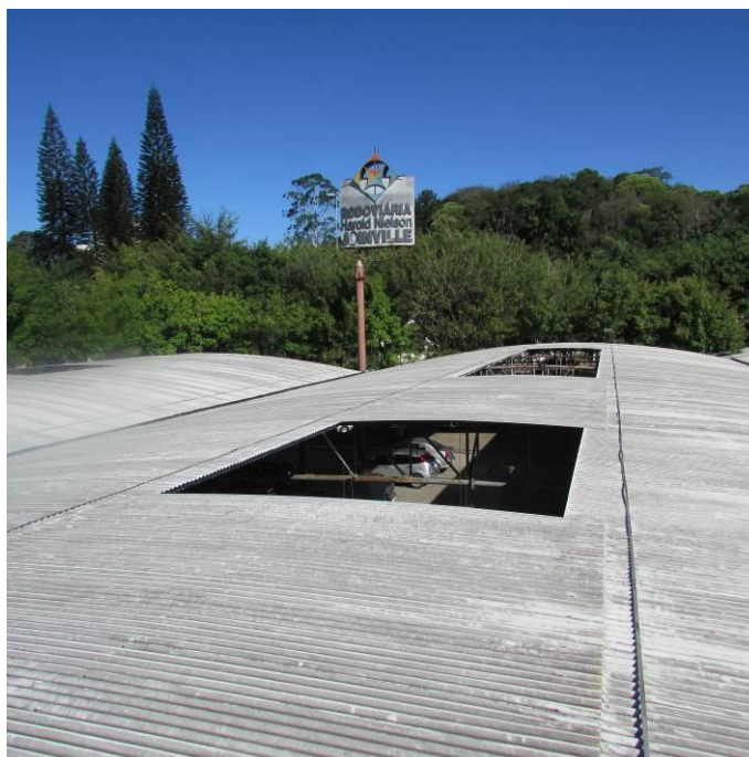
Figura 40 - Vista global das telhas de cobertura
